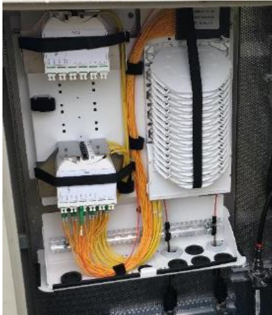
BELUGA PRO 4 für 4x 1:32 Splitter auf Stecker LCAPC inkl. Beschriftung
